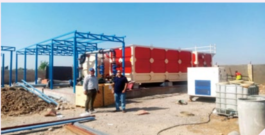
▲ 中国石油在伊拉克为Ishbelia村建设饮用水综合体扩建项目
