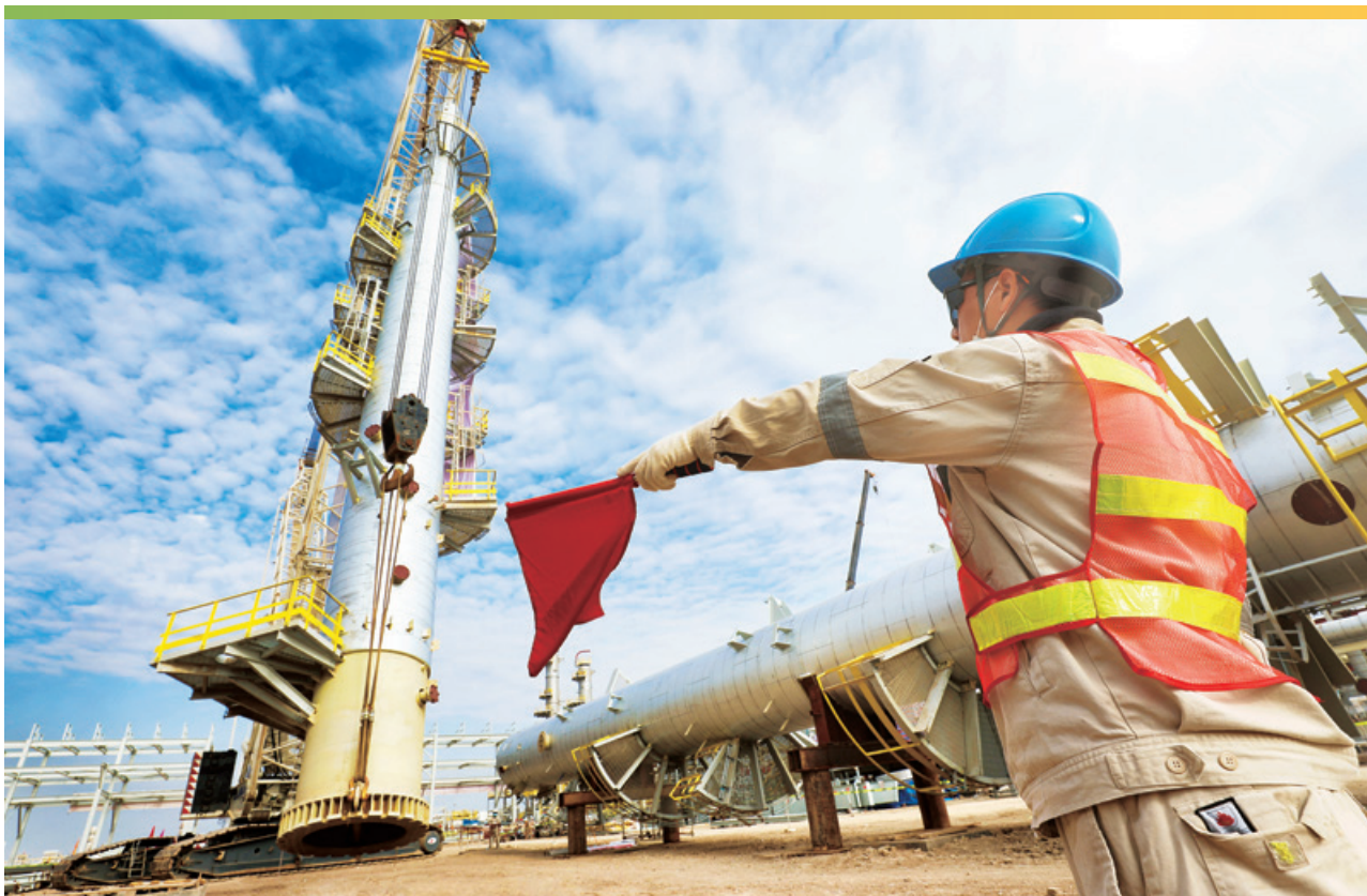
▲ 安全守护下的塔器吊装
