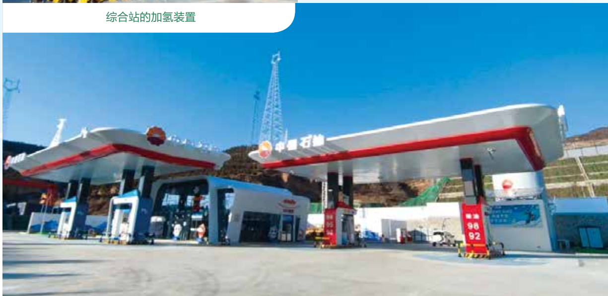
中国石油首座新形象标准综合能源站
