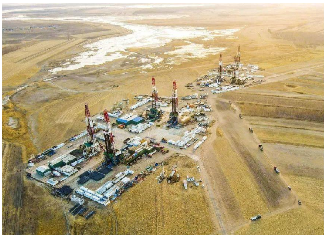
古龙页岩油试验区 1 号井工厂平台施工现场。
