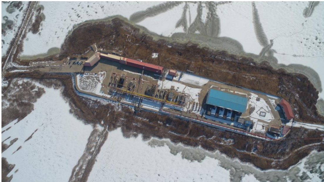
大张坨储气库
