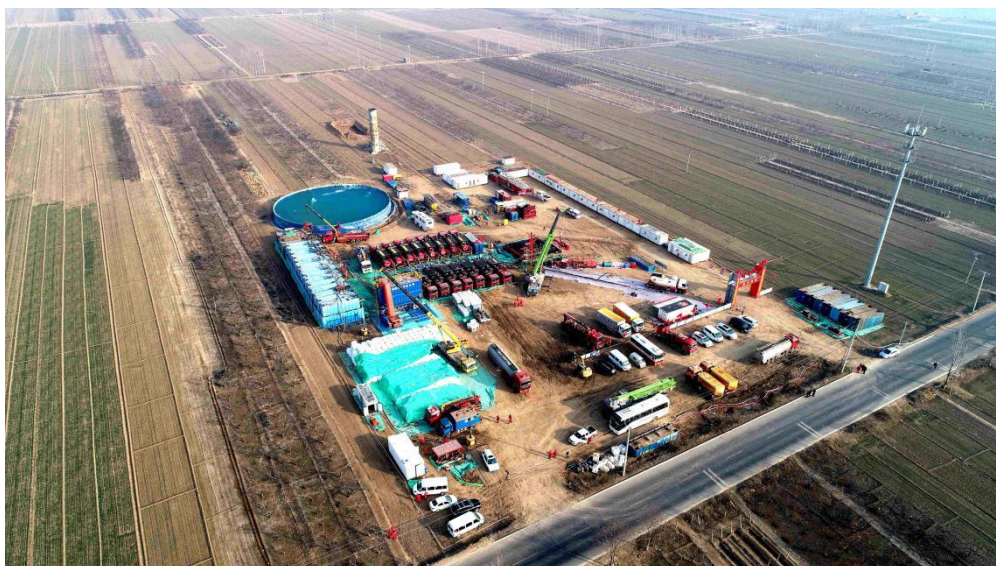
图 3 SY1 井桥射联作分段压裂施工现场
